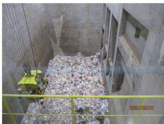
エネルギー回収型廃棄物処理施設 (宇城市)
