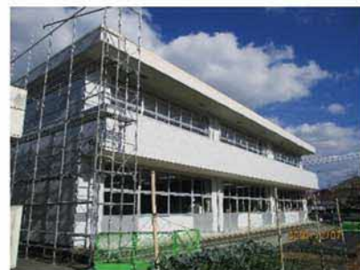
中央小学校プレハブ棟
