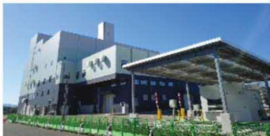
エネルギー回収型廃棄物処理施設(宇城市)
