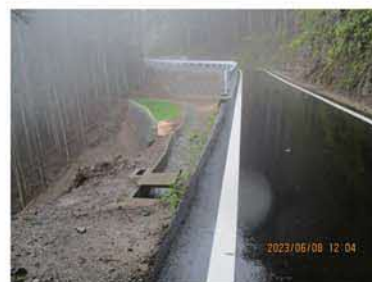
町道三本松千間線復旧工事現場
