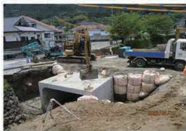
町道土喰大窪線(堂面谷橋) 災害復旧工事 進捗率60%
