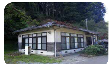
解体撤去された椿公民館
