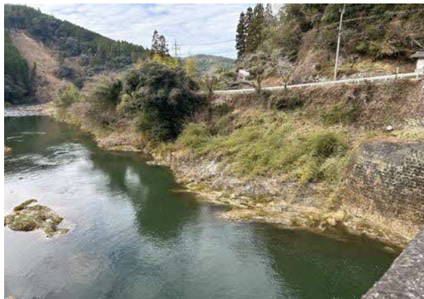
霊台橋下流右岸の整備(清掃前)
