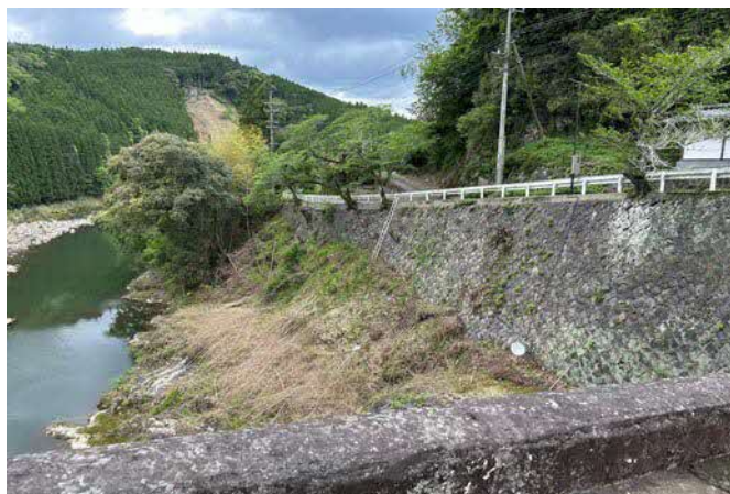
霊台橋の石垣部(作業後)
