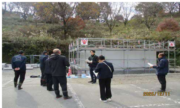
上中郡送水ポンプ場・進捗率70%
