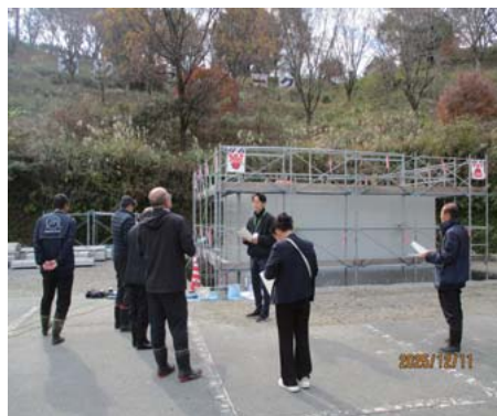
上中郡送水ポンプ場・進捗率70%
