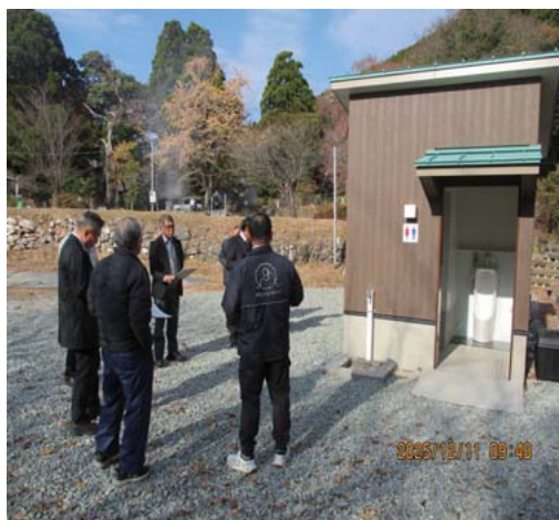
新築トイレ整備(甲佐平)
