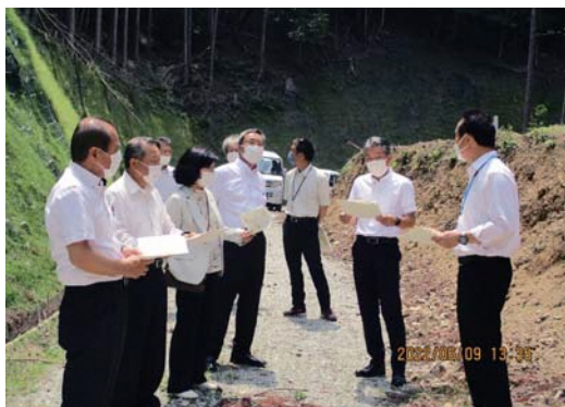
林道早楠線開設工事現場
