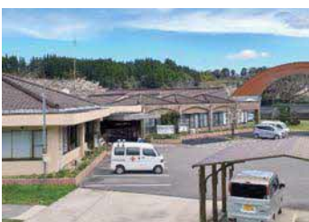
改修が必要な美里町老人福祉センター
