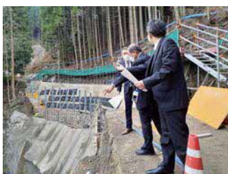
復旧工事現場（山出）
