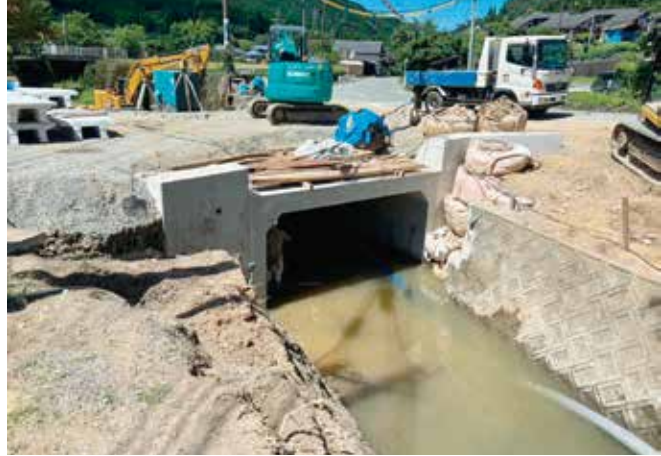
堂免谷橋(町道土喰大窪線)現在 復旧に向けた工事が着実に進んでいます
