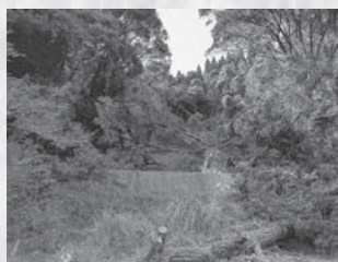
令和7年8月豪雨による宝勝寺観音堂被災状況①
