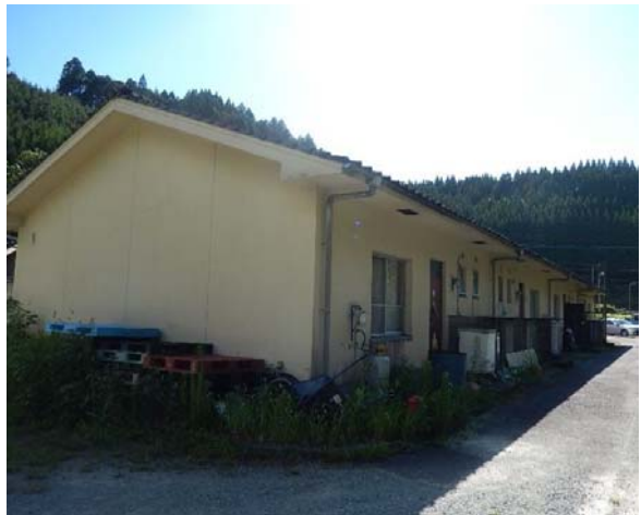
簡易耐火平屋（玄関側）
