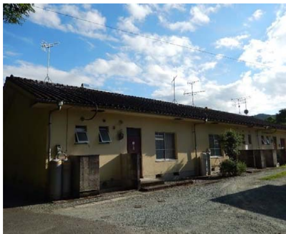
簡易耐火平屋（玄関側）
