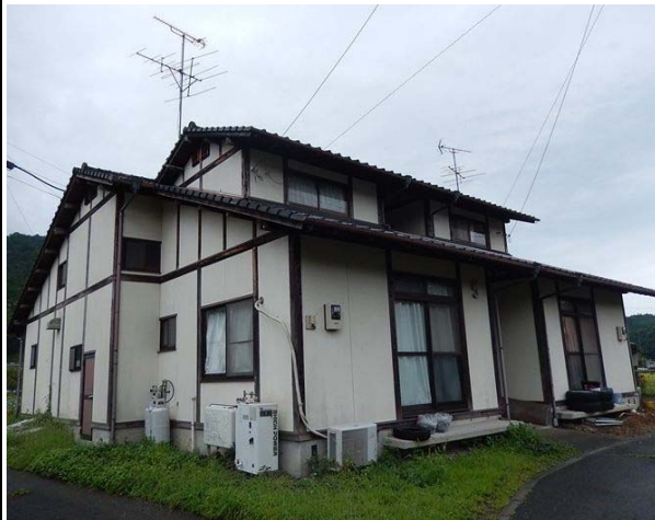
木造2F（玄関側）
