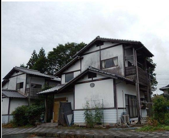
木造2F（玄関側）
