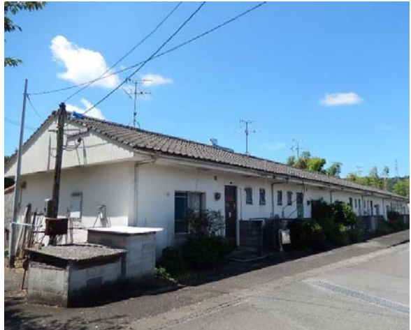
簡易耐火平屋（玄関側）
