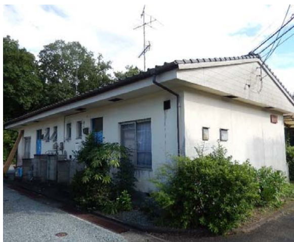
簡易耐火平屋（玄関側）
