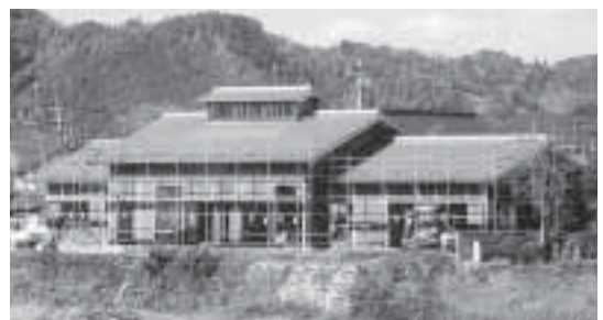
▲建設工事が進む中央町高齢者地域ふれあいセンター
