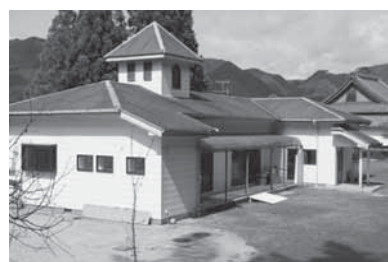
▲新しくオープンした「美里町老人憩いの家」の外観
