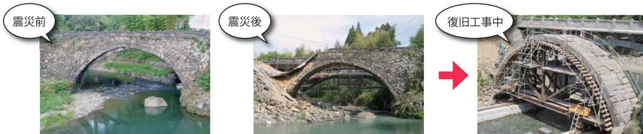
町道福佐線（第二二保橋）災害復旧工事により復旧工事中の第二二保橋
