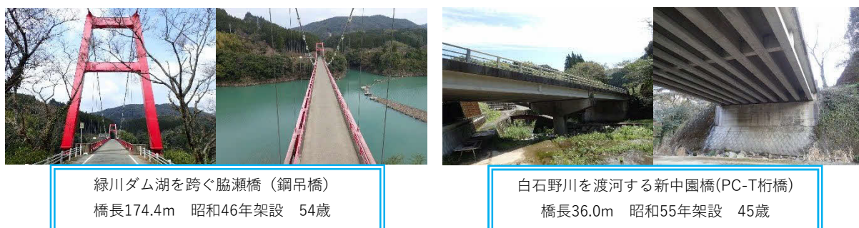
写真1.1 町内管理橋梁の例
