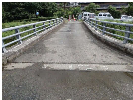
走行面の変状（路面の凹凸）
