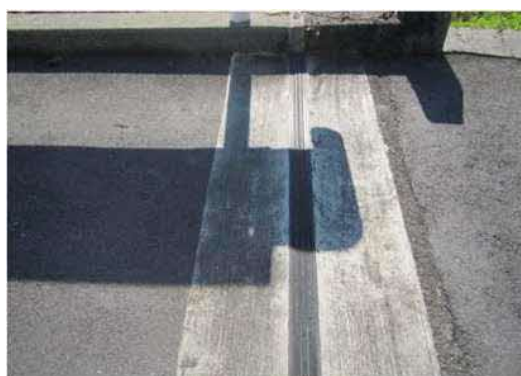
補修後（伸縮装置の交換）
