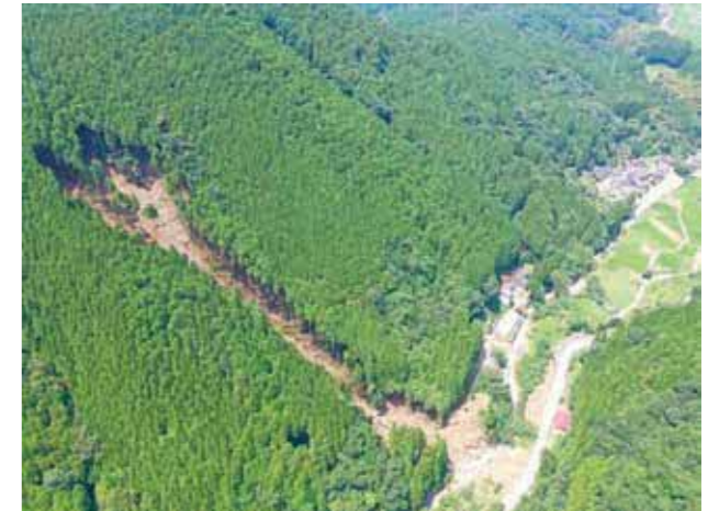
坂貫大平山腹崩壊
