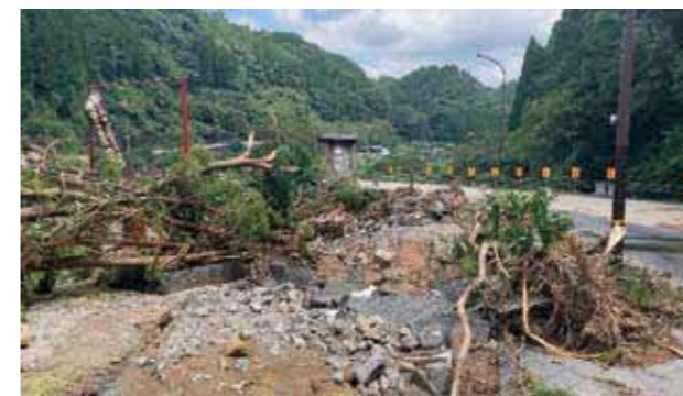
国道 218 号線被害状況
