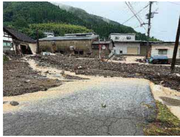
町道土喰一の谷線被害状況
