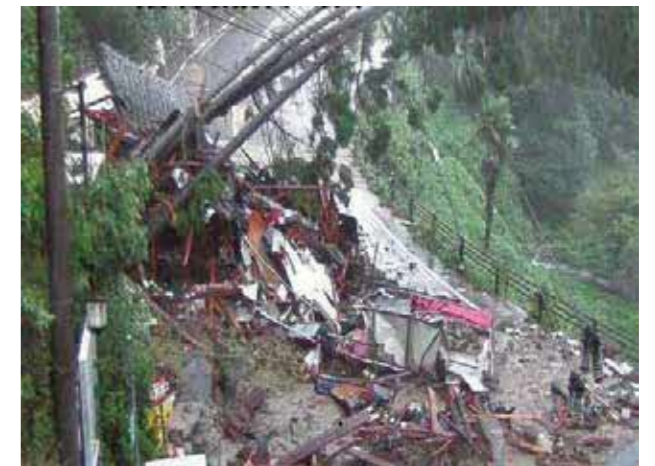
国道 218 号線被害状況
