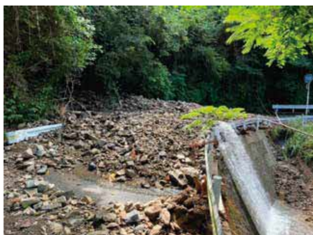
県道清和砥用線被害状況
