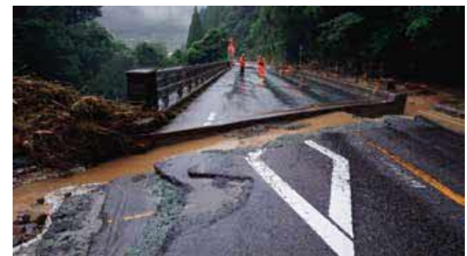
国道 218 号線被害状況
