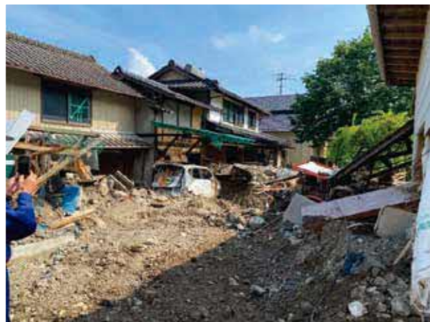
宅地内土砂堆積被害状況
