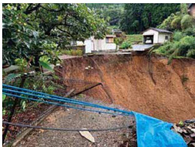
国道 445 号線被害状況
