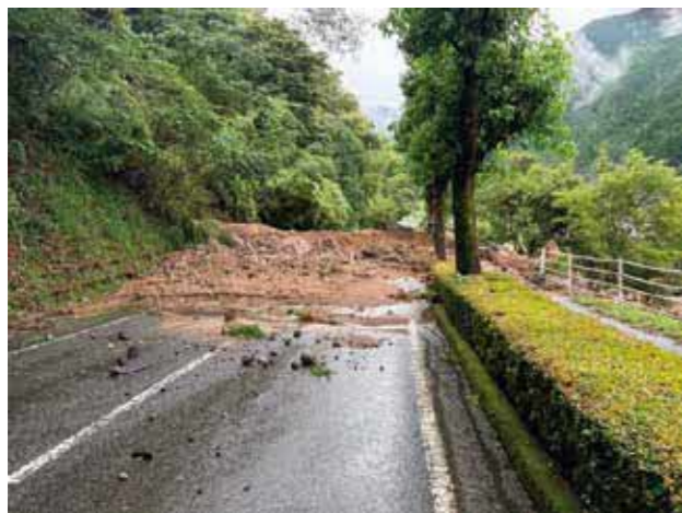
国道 445 号線被害状況
