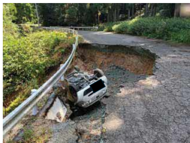
県道清和砥用線被害状況
