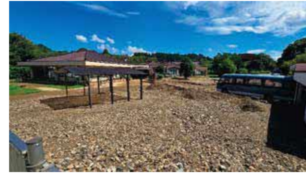
老人福祉センター被害状況
