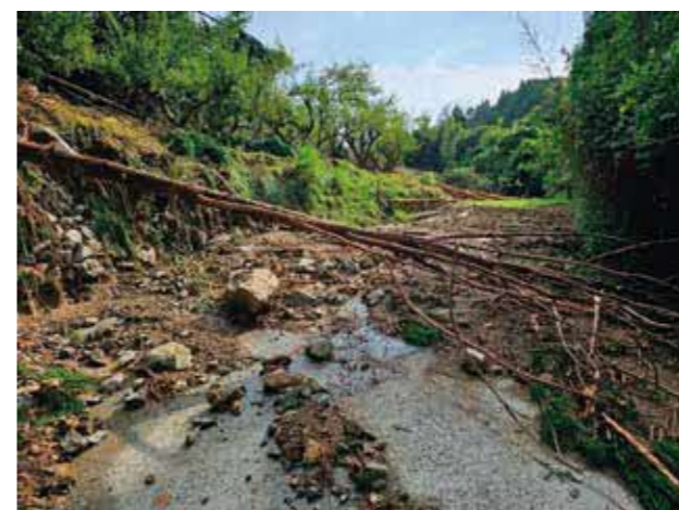
町道石原線被害状況
