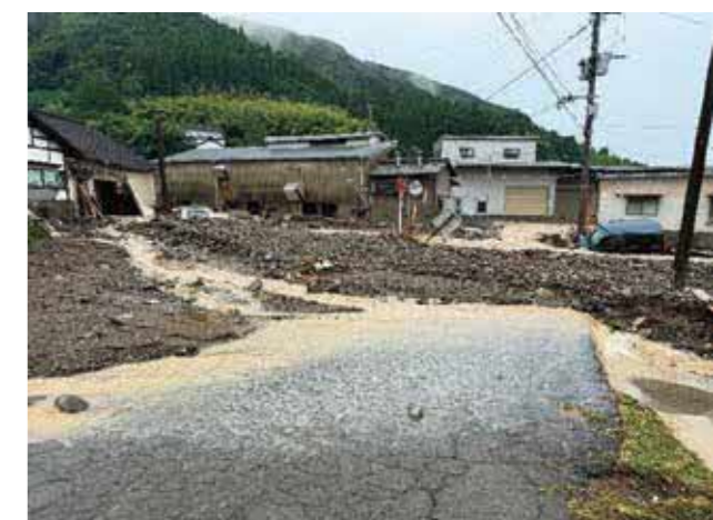
町道土喰一の谷線被害状況
