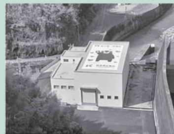
緑川第一発電所
