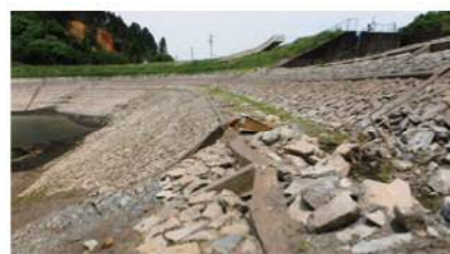
大切畑ため池における法面圧縮崩壊の様子(株式会社パスコ撮影)
